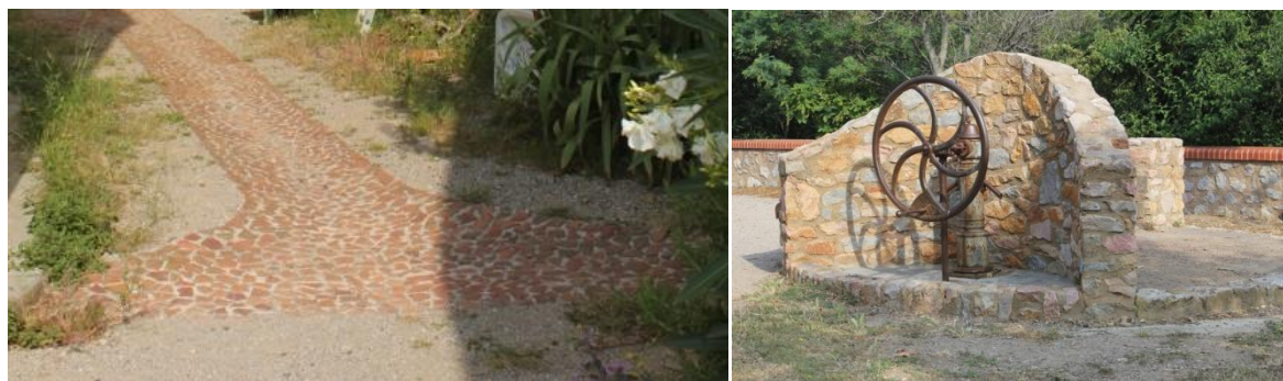
Caniveau en terre cuite cassée / Mise en scène d'une ancienne roue de puits (place derrière la Mairie).
