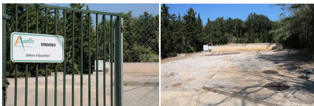
Site de la station d'épuration de Tordères.
