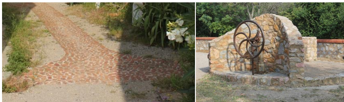
Caniveau en terre cuite cassée / Mise en scène d'une ancienne roue de puits (place derrière la Mairie).
