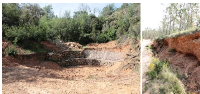
Zone d'érosion et ouvrage de protection.
