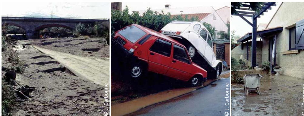
Dégâts occasionnés par la crue de 1992 à Saleilles.
