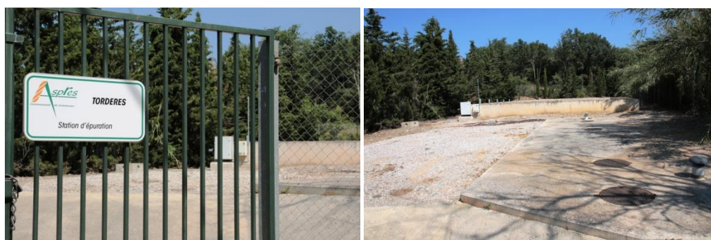
Site de la station d'épuration de Tordères.
