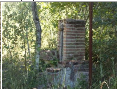
Puits communal n° 9e
