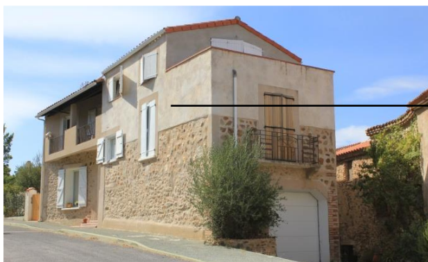
Maison de ville ou « habitat simple » en entrée de village (est).
