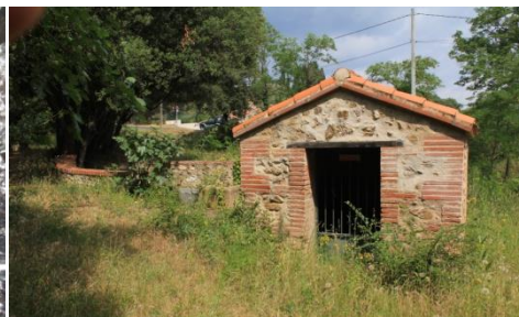
Puits n° 9j, en entrée de ville est
