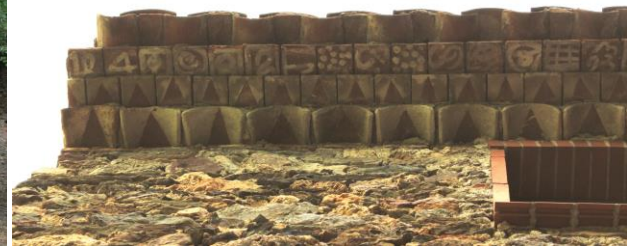
Avant-toit en tuiles de terre cuite peintes
