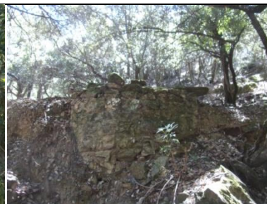
Puits communal n° 9g
