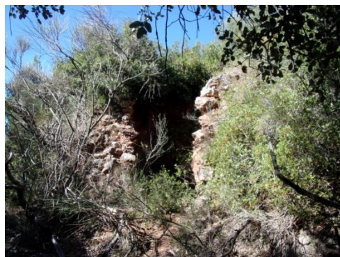
Four à chaux 10a, sur parcelle n° 356
